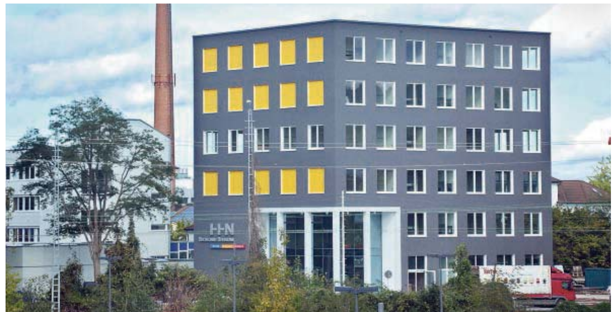
Auf sechs Etagen mit rund 3200 Quadratmetern Fläche bietet das neue Gebäude zusammen mit dem ehemaligen Gebäude der HVG jetzt rund 1000 Studierenden auf dem Campus am Europaplatz viele Möglichkeiten.
